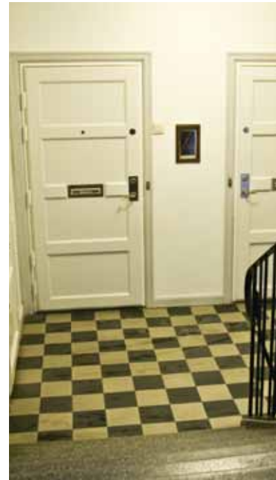
Befintlig dörr till vänster, och ny säkerhetsdörr till höger producerad efter den gamla dörrens design.
