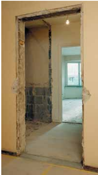
Väggen kan få skador om man måste plocka bort den gamla karmen
